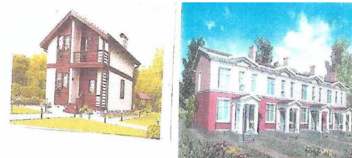
Рис.10. Дома эконом-класса из песчаного бетона а) коттедж 122 м 2 б) таун-хаус на четыре семьи
