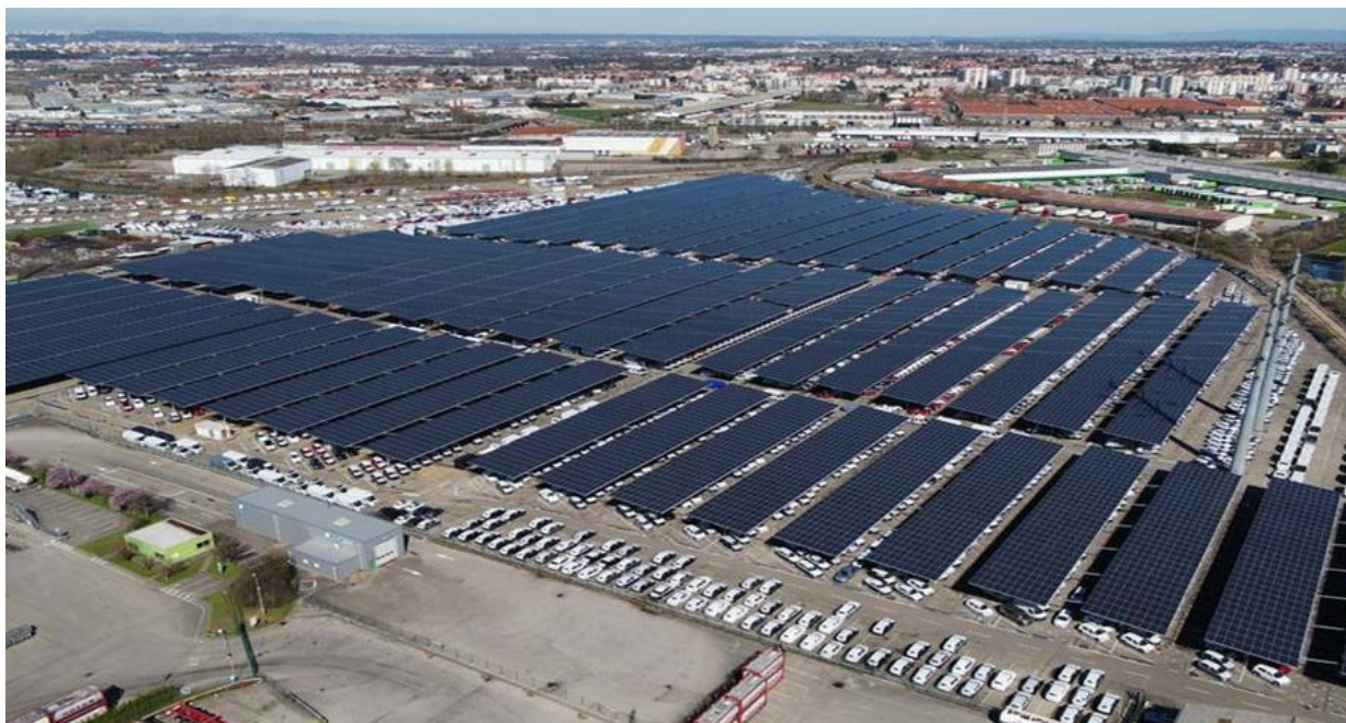
Рис.3. Автостоянка с навесами в г. Корбас
